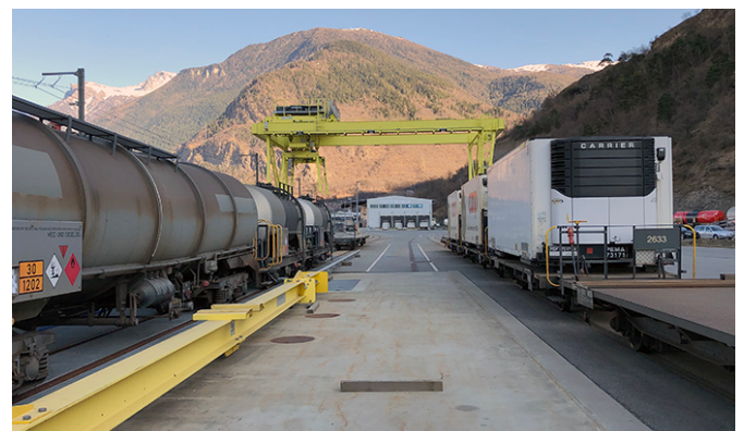
Im Anschluss an die GV 2022 können Interessierte an einer geführten Besichtigung des Güterterminals Bockbart in Visp teilnehmen (Alle Fotos: Beat Moser).
