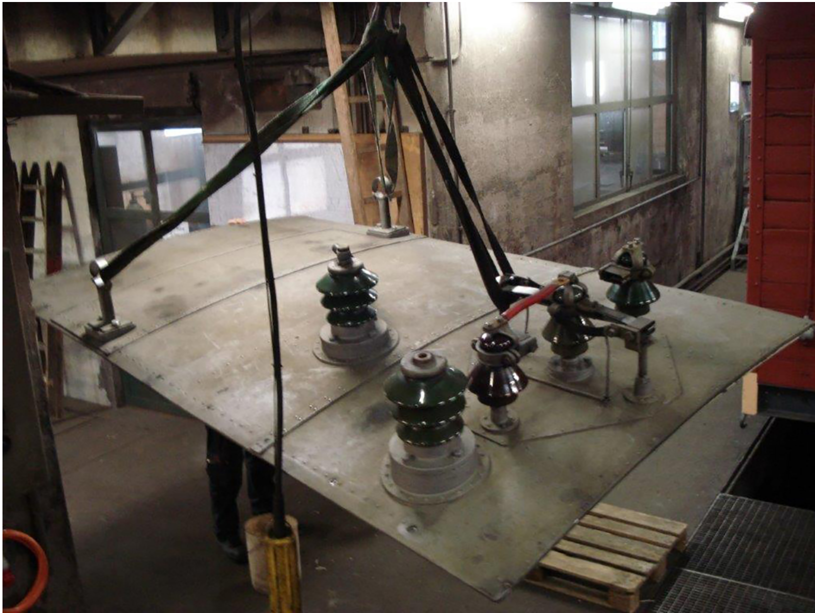
Ein Dachelement wird mit dem Kran abgehoben.
